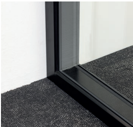
Decken-, Boden- und Wandanschluss zweischalig
